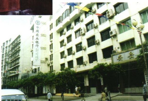
▶安岳支行办公大楼
