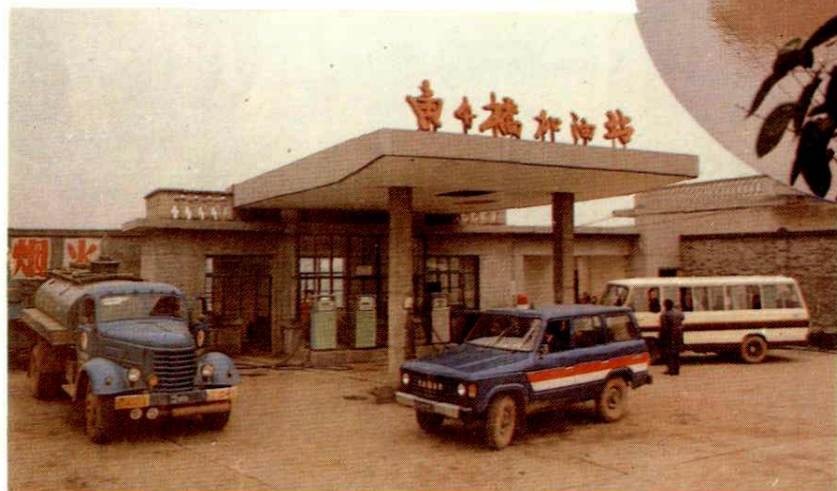
东升桥加油站
