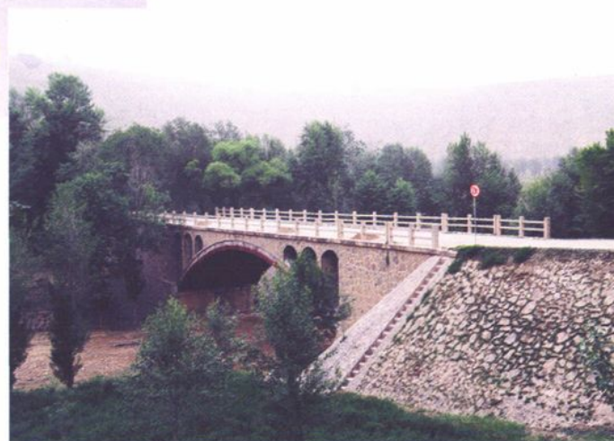
义岗川镇悠江铺桥
