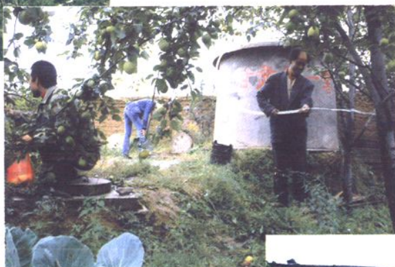
景木岔“121”雨水集流工程
