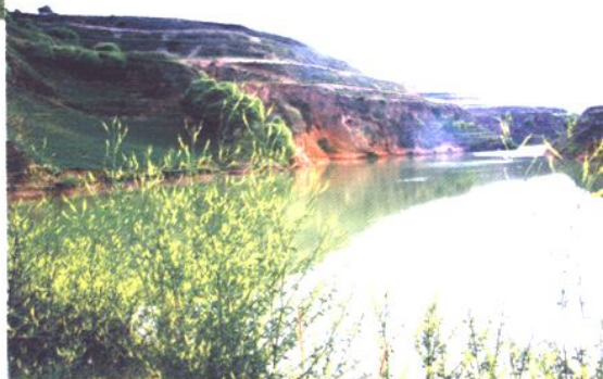
平襄镇廉家堡水土保持治沟骨干坝
