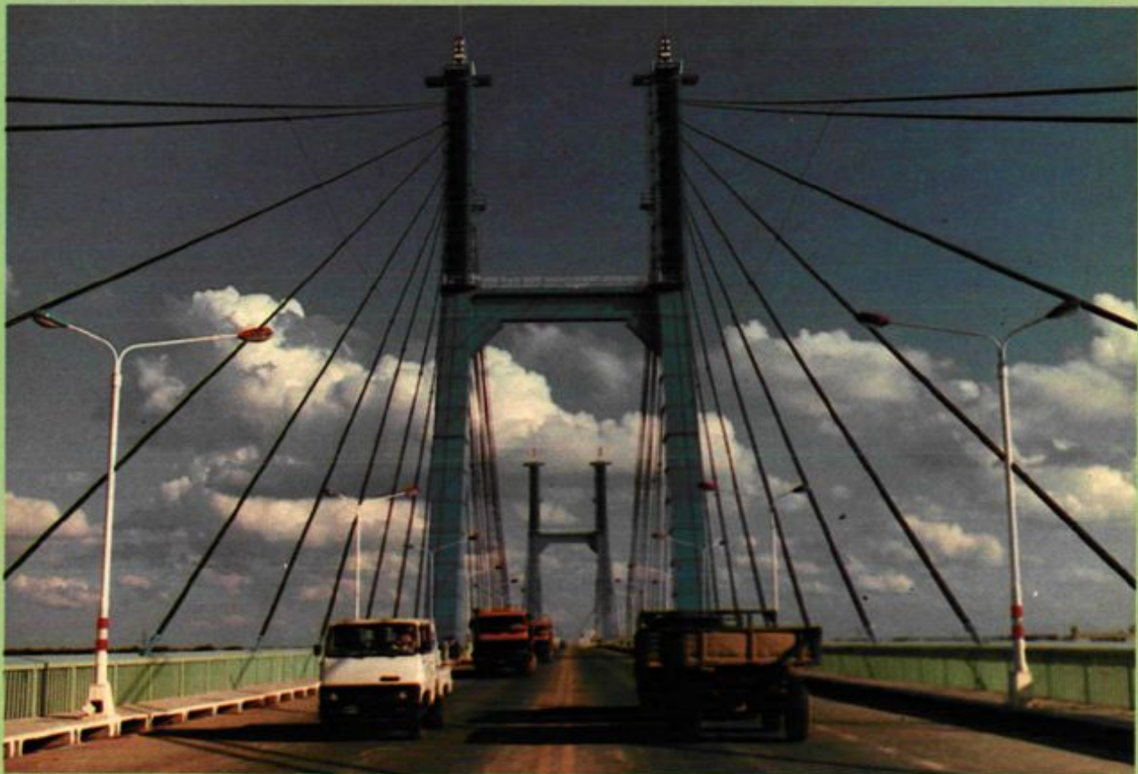
1. 矗立在垦利县城北端的胜利黄河大桥 王俊生 摄
