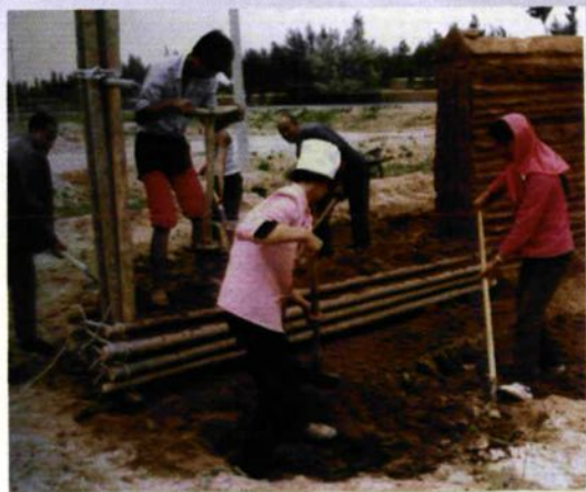
传统的板筑形式——打土墙。
