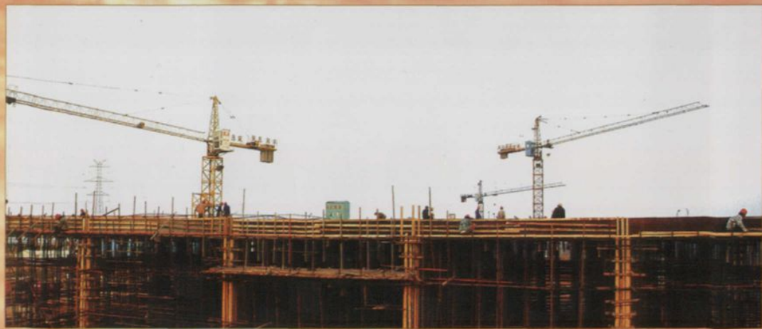
2006年10月,紧张忙碌的培训中心施工现场
