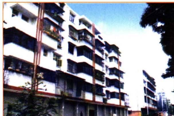
城镇居民住宅楼
