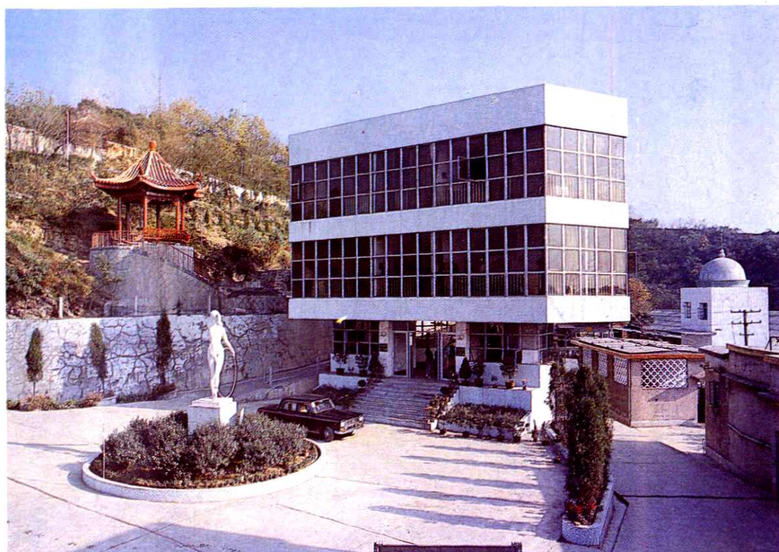
云山制药厂办公楼
