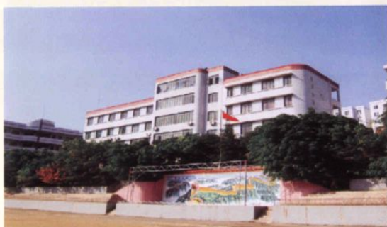
通江县实验中学综合楼
