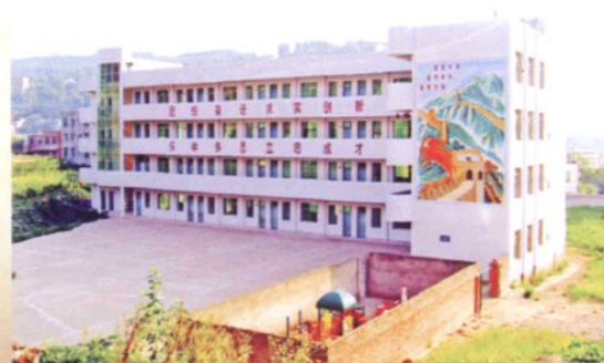
诺江镇五完小教学楼
