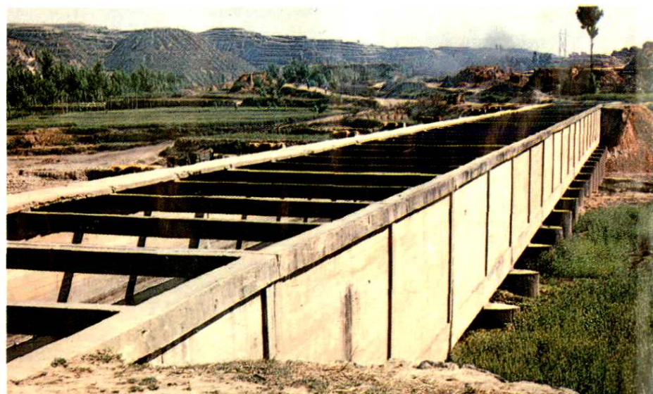
七一渠团柏渡槽
