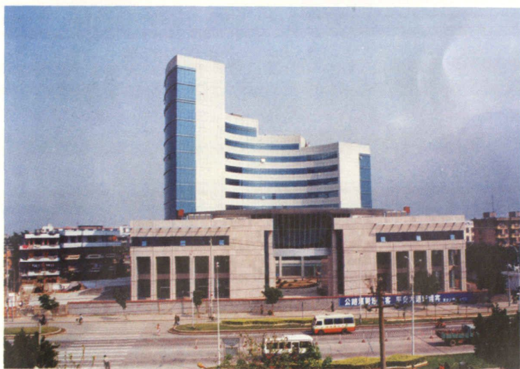
福州市科技信息中心大楼
