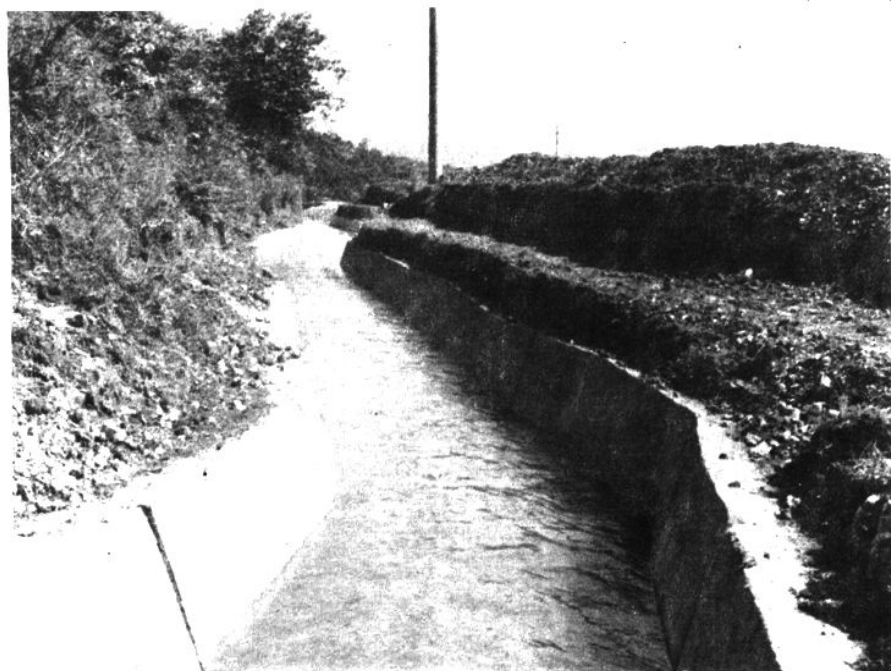
黑塘水库防渗灌渠
