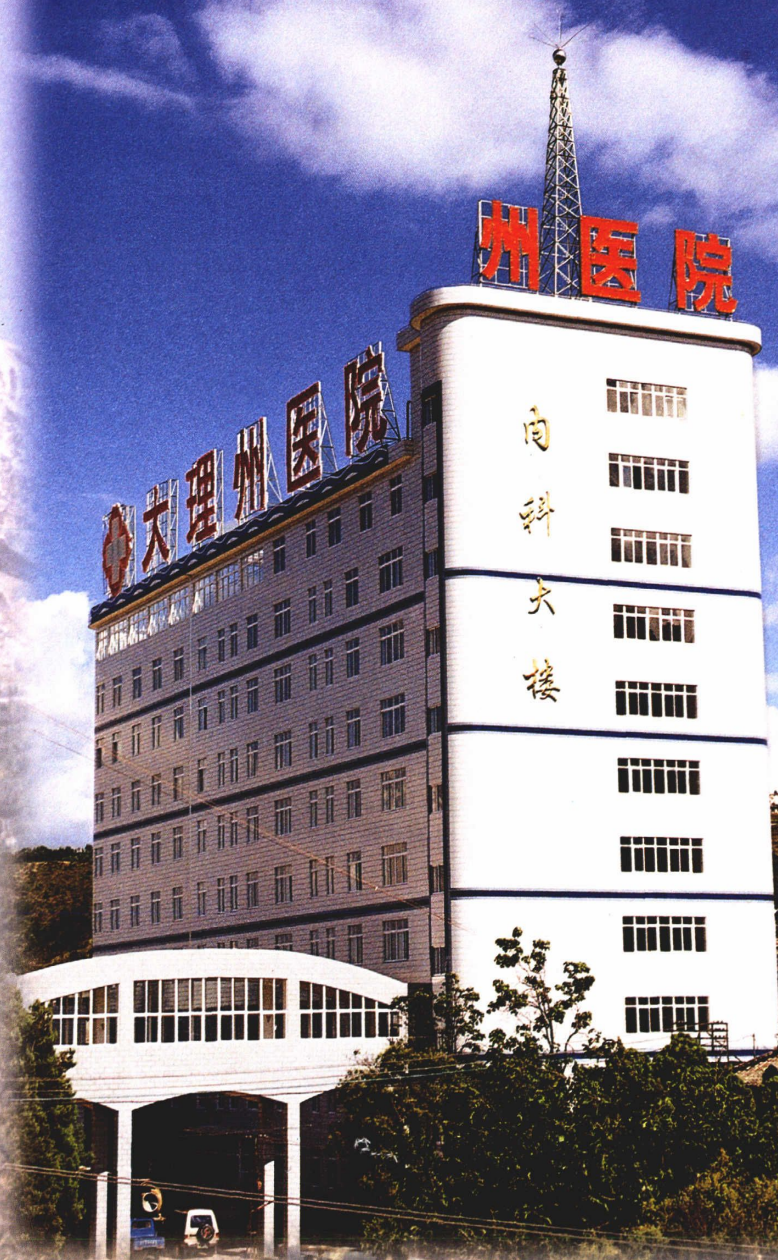
投资 2000 余万元，建筑面积 10699 平方米的内科大楼。2000 年 11 月 8 日投入使用。
