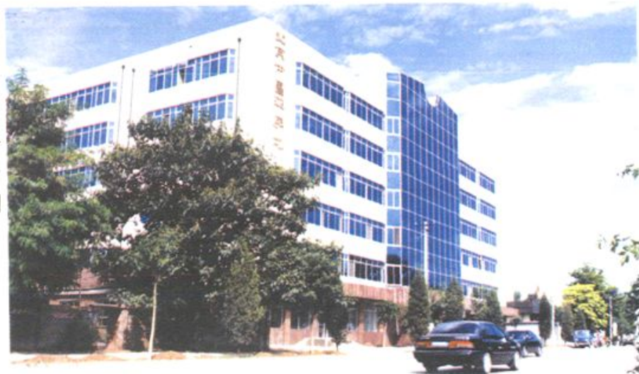
昌平 房地产开发总公司 办公楼
