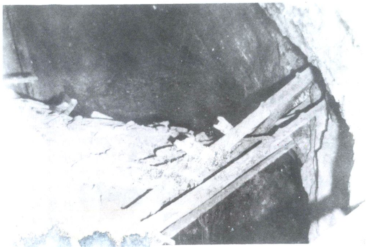
洞安放“烧爆法”灶头的采矿平台
