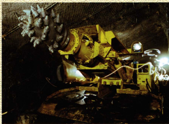
高强度联合掘进机掘进效率大幅度提升
