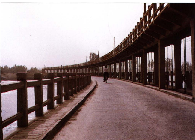
塔里木拦河闸
