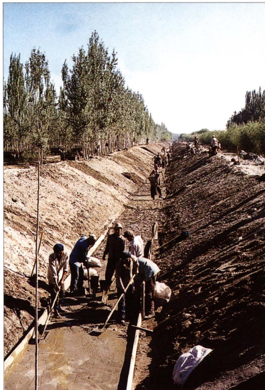
修建防渗渠道
