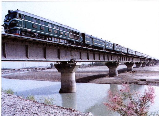
阿克苏河铁路大桥
