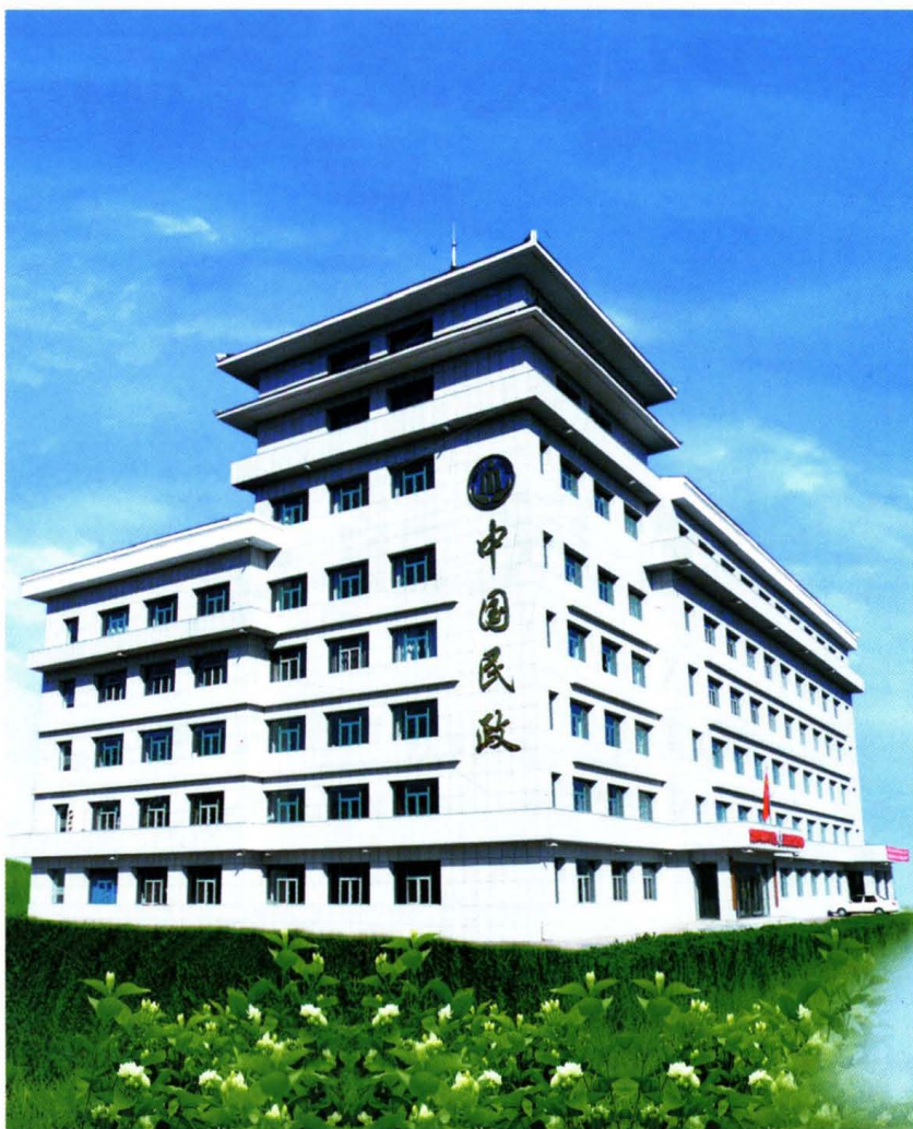
延边州民政局办公大楼
