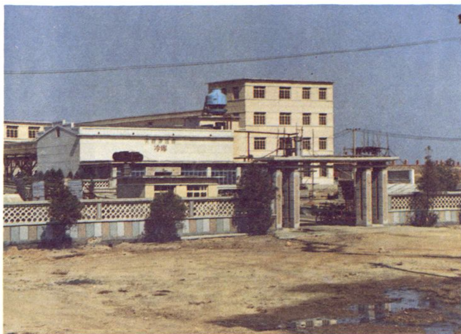
锦县天桥乡海水养殖场冷库
