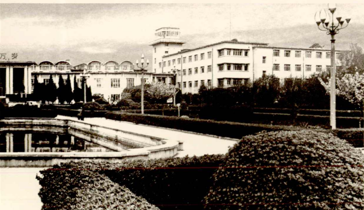
20世纪60年代的机场候机楼
