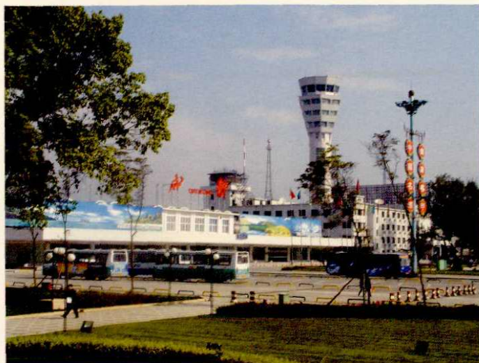
20世纪90年代的机场候机楼
