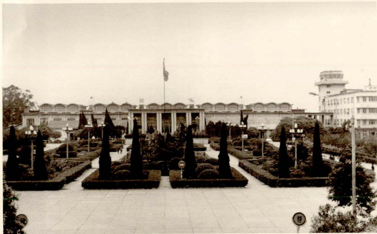
20世纪80年代的机场候机楼
