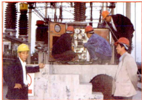
▲生调部主任韩虎成(左一)等在检修变电设备
