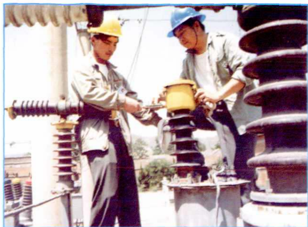
▲维护变电设备
