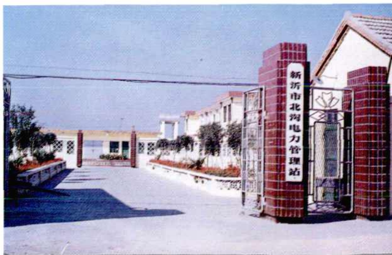
北沟电力管理站
