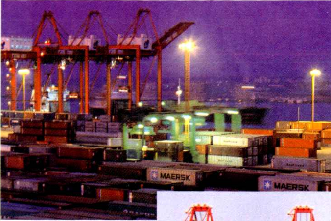
上海港集装箱码头的夜景
