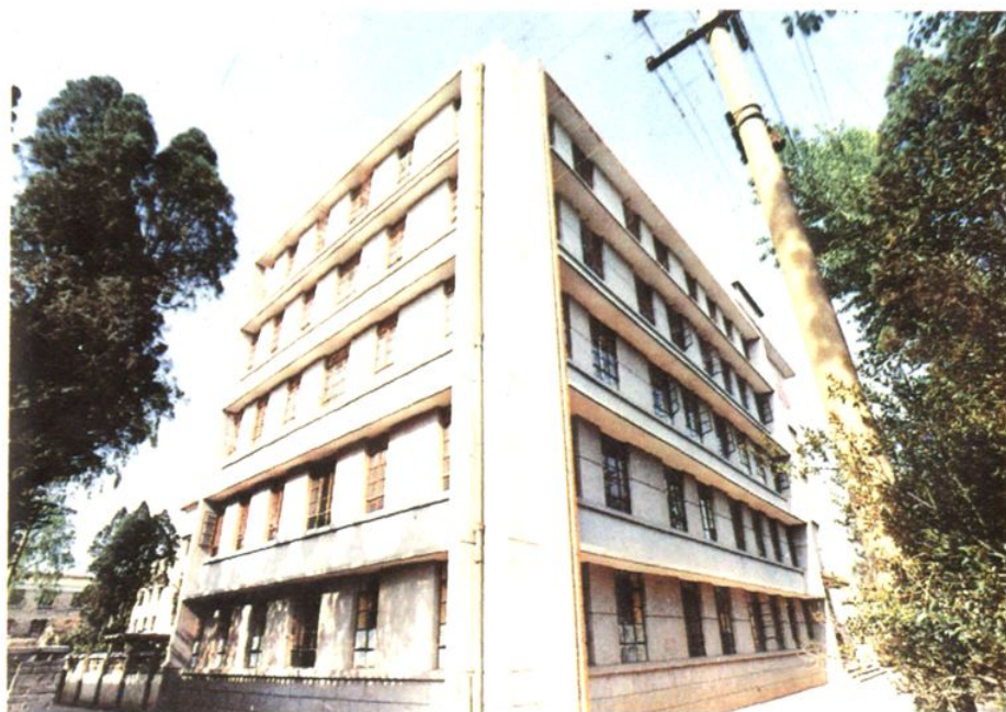
宣威县人民医院住院部
