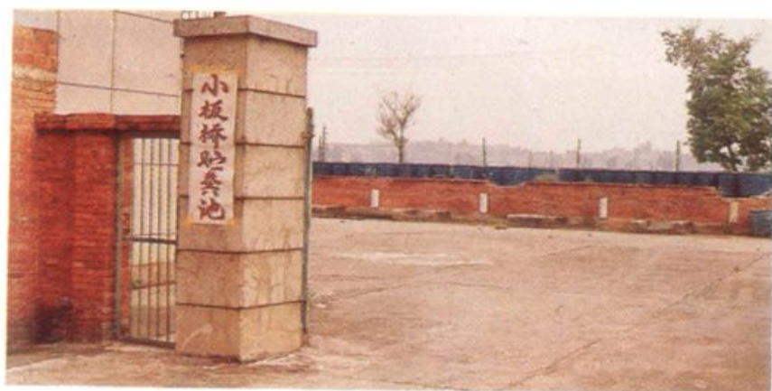
小板桥贮粪池
