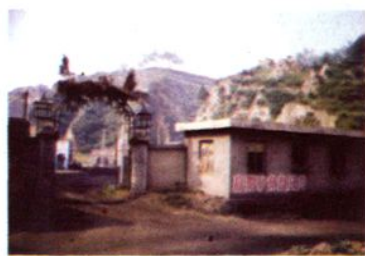
高阳矿角盘风井
