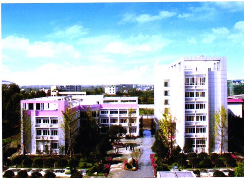
双流县人口和计划生育局综合楼、双流县计划生育服务站于2008年底竣工投入使用。
