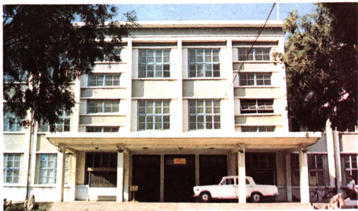
县供销社办公大楼
