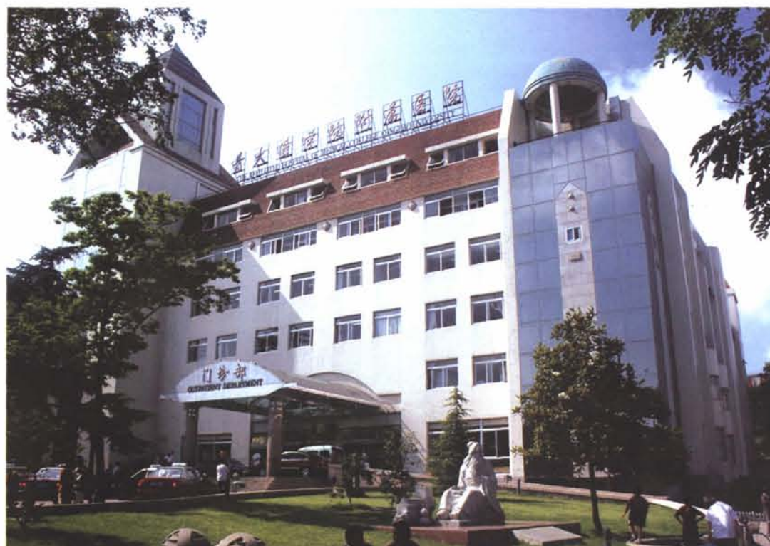
现医院门诊楼外景
