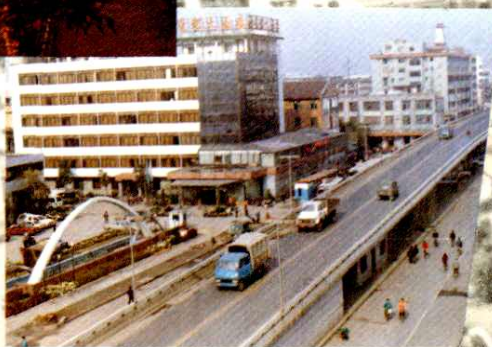
衡陽市城明源路高架立交橋
