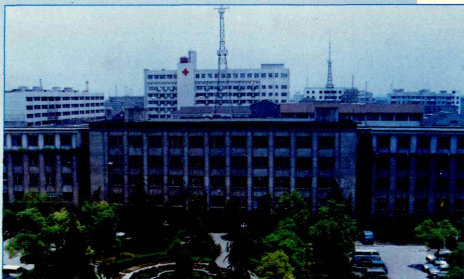
衡陽市工業、計劃、外經、基建等主管機關大樓
