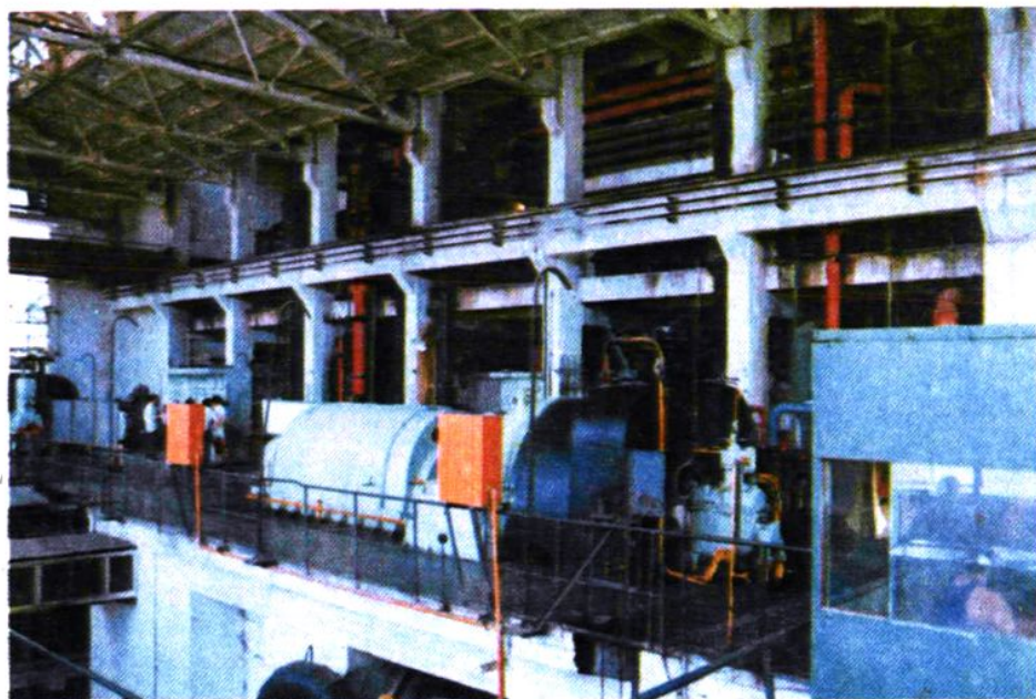
◀ 公司 最早安装 的工程之 一一驻 昆解放军 化肥厂2. 万瓩汽轮 发电机组 。
