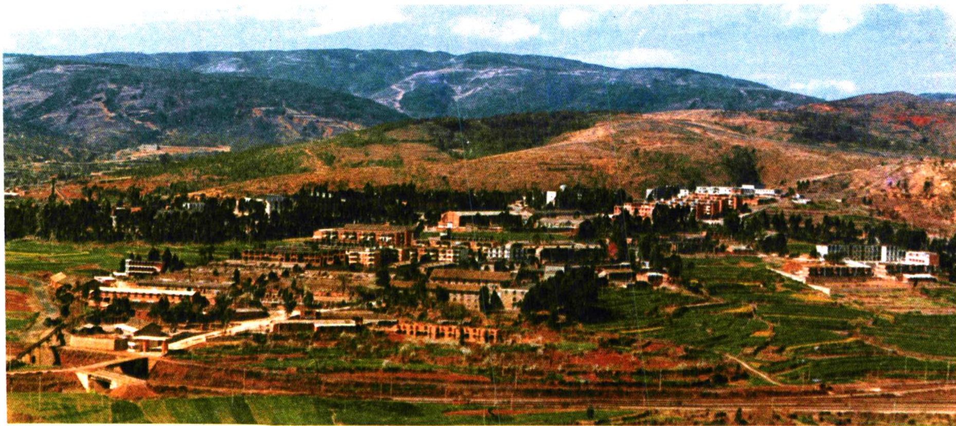
▲ 位于昆明市海口白塔村的云南省化学工业建设公司基地。
