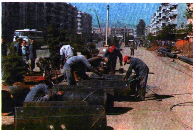
► 公司安装工人为昆明 煤气工程紧张施工。
