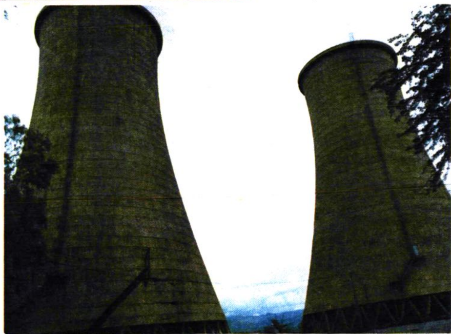
▼ 公司最早施工的工程之一 驻昆解放军化肥厂的冷却塔。
