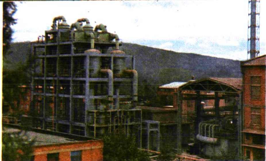
▲ 公司安装的由日本引进的云南磷肥厂重过磷酸钙浓缩装置。
