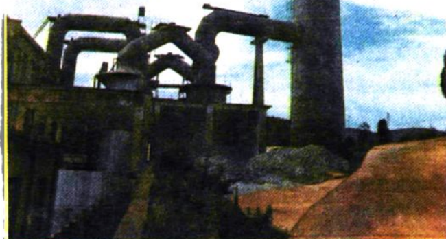
► 公司承建的云南磷肥厂 水泥车间的氟气处理、回 收、排气装置。这个70米钢 筋混凝土烟囱，采用移动 式非定型钢模施工工艺施工。
