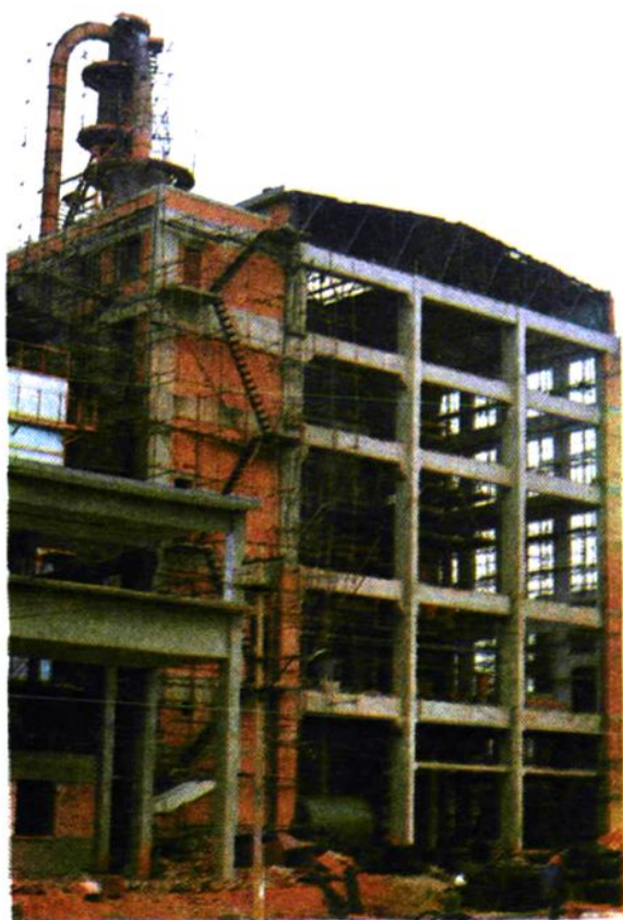
► 公司正在为沾益化肥厂安装65吨锅炉。
