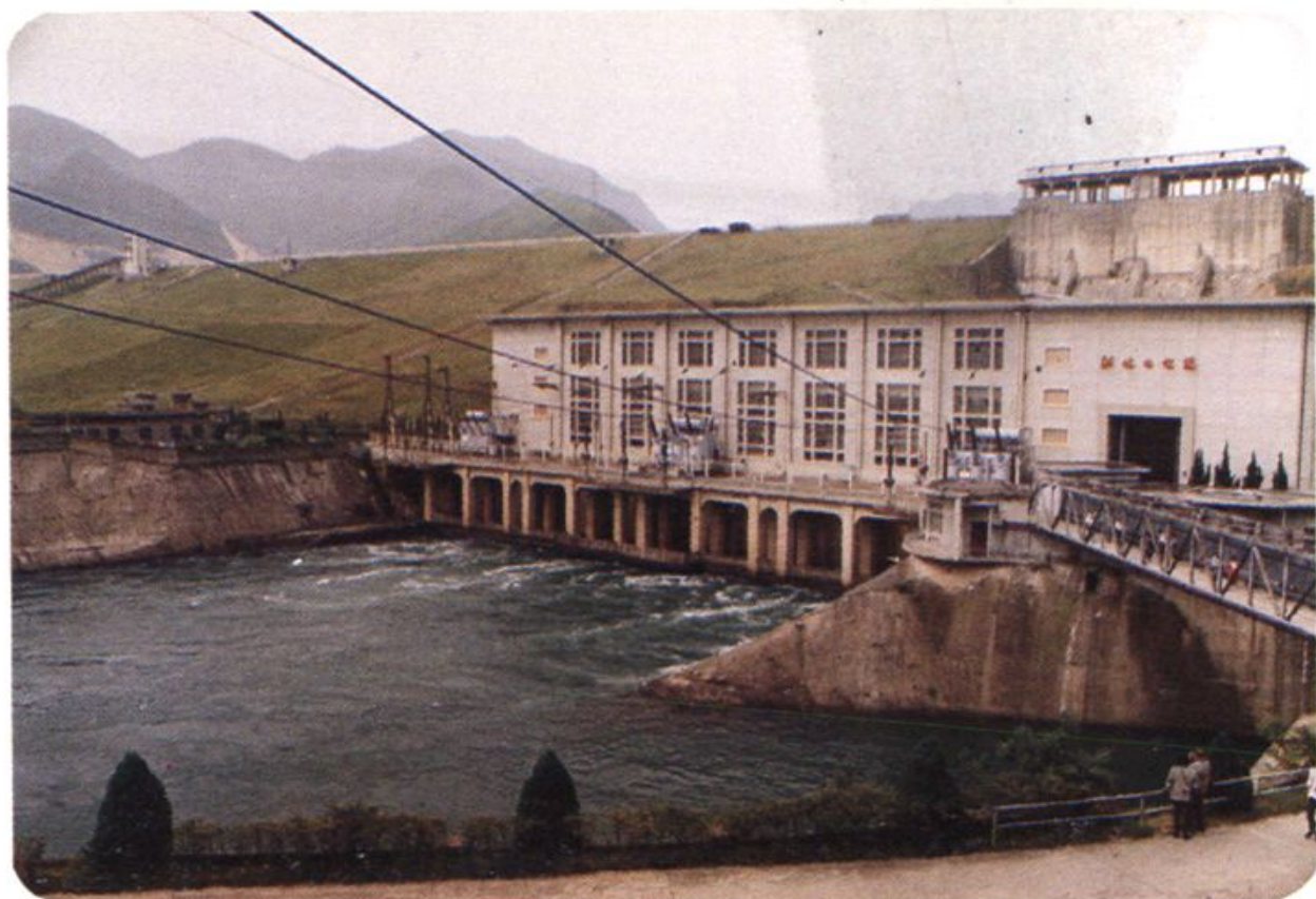
發電廠房外景
