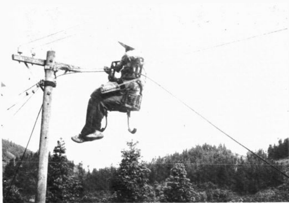
线务员在高空作业
