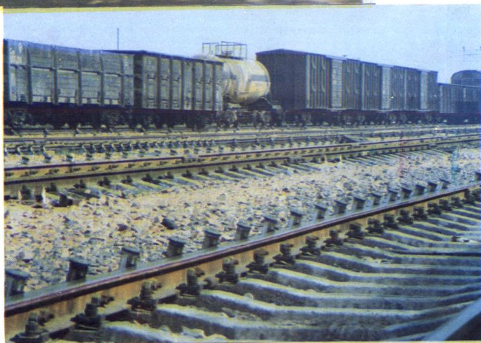
北运转场编组线上设置的减速顶
