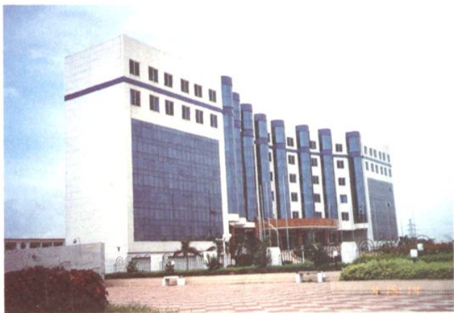
黄圃镇人民政府办公大楼
