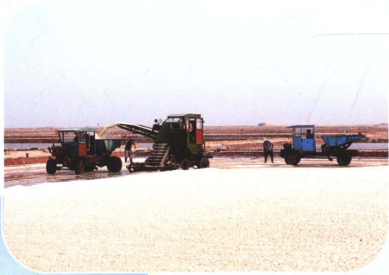
金星盐化施工现场
