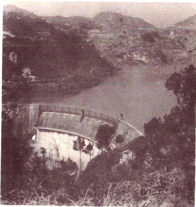
长沙坝水库坝高52.8米，总库容4,530立方米。以设计先进、造型新颖在国际上享有声誉。
