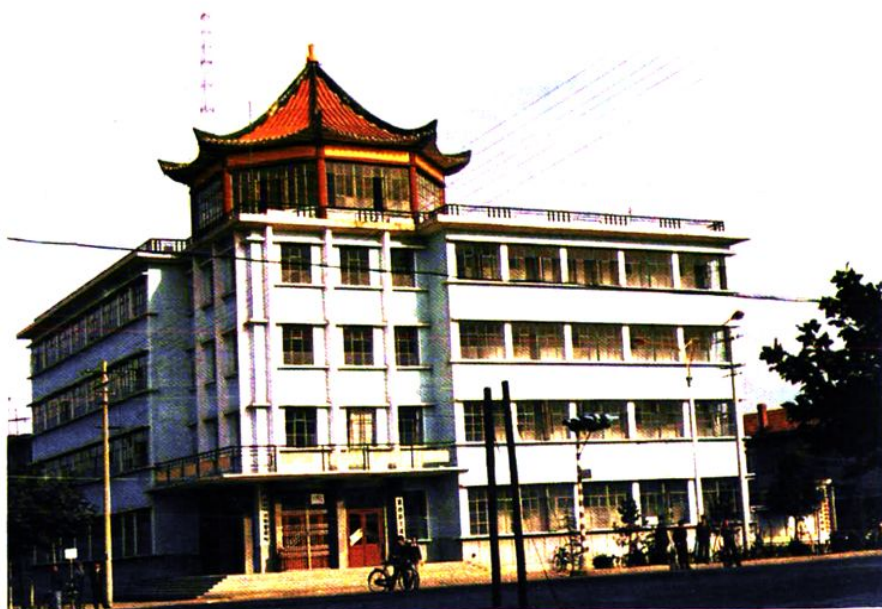
交通局办公楼
