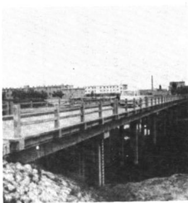
烟青线前疃朱河大桥
