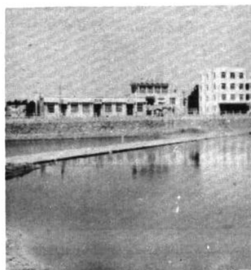
旧烟青路南洙河漫水路桥
