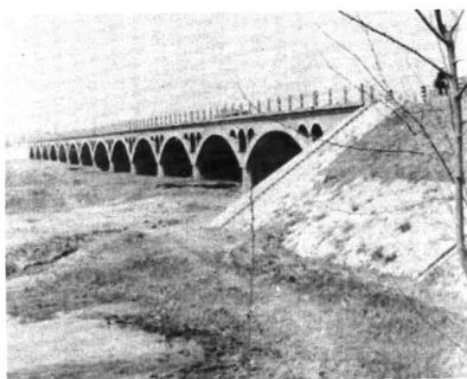
太古线大沽河沙埠桥
