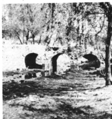
原青烟路水集东三孔石拱桥遗迹
