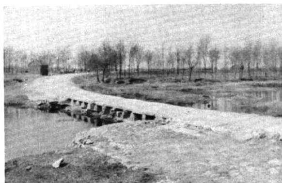
太古线洙河房家疃过水桥
