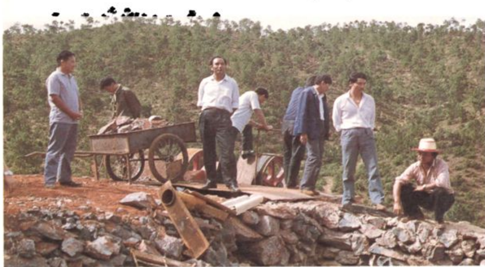
1992年10月县纪委监委创办麻地坑采石厂竣工投产
