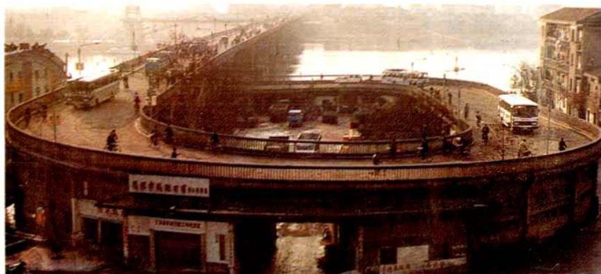
兰溪市兰江大桥
