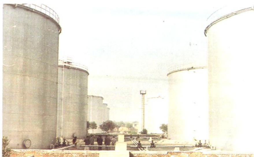
西安石油采购供应站轻油罐区
