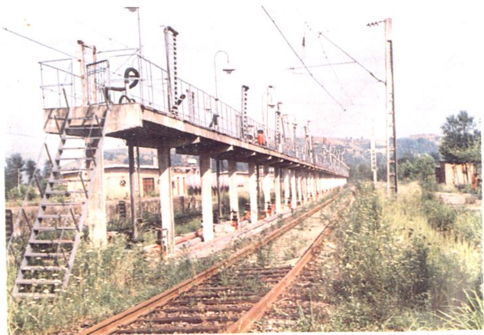
安康石油分公司五里油库电气化铁路栈桥
