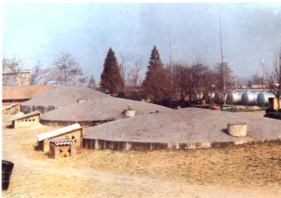
华县石油公司油库土油罐群
