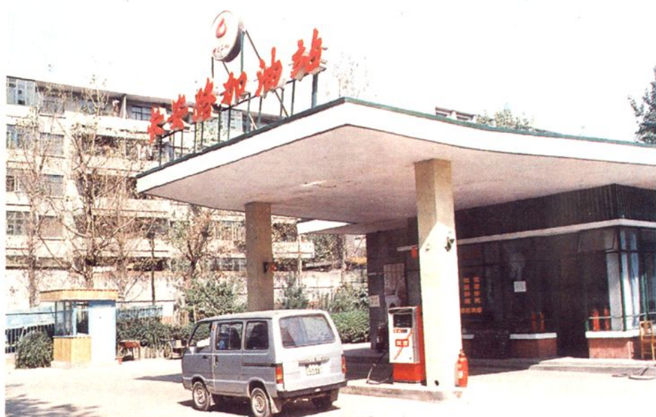
西安市石油公司长安路加油站
