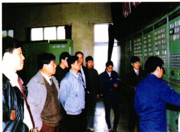
◆ 局长邹西庚(左二)、副局长程凤舟(左一)检查红石坡 220 千伏变电站增容工程竣工投运
