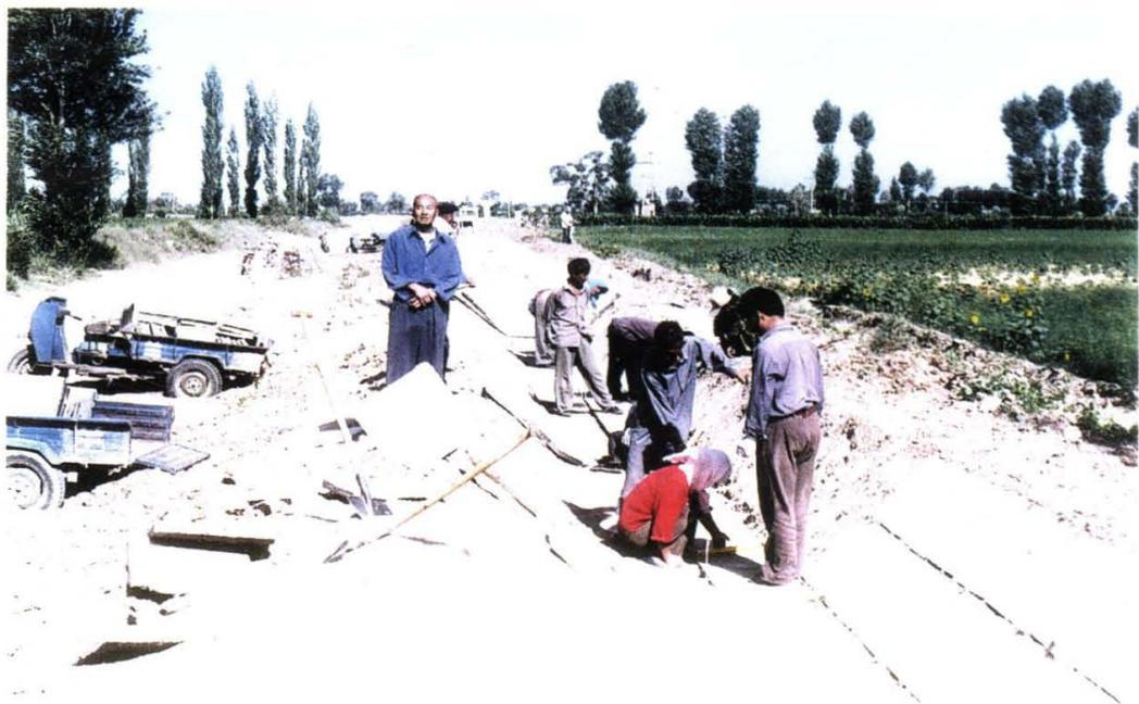
黄岭人民兴修水利、挖管道，安装自来水施工现场。
