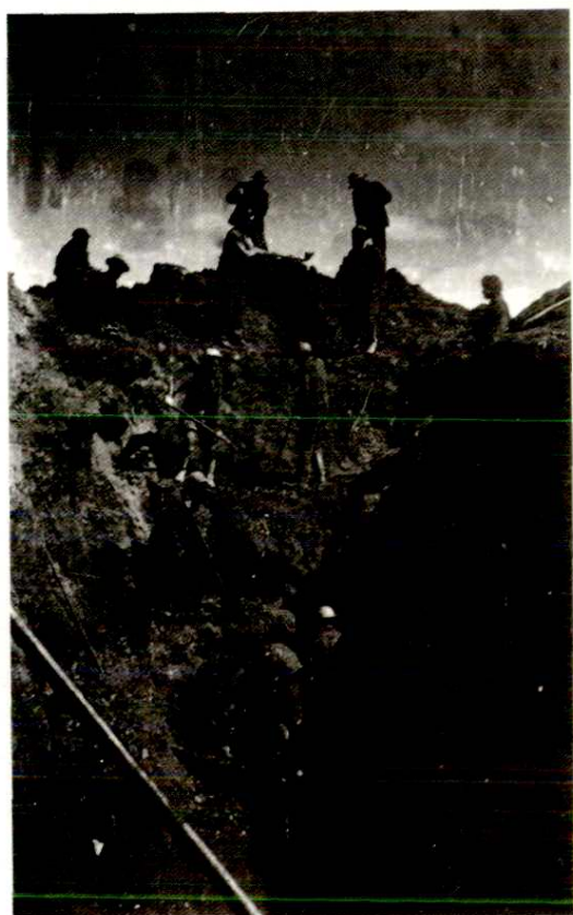
土门格拉煤矿挖掘探槽采挖浅部资源
