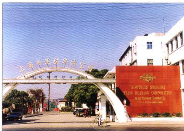
上海外运张华浜公司，储存面积13万平方米，设有铁路专用线，全国各地进出口物资均可直达
