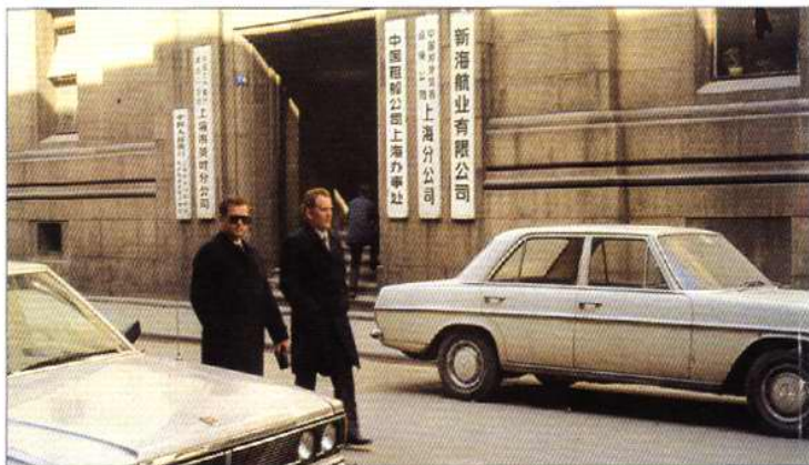
中国对外贸易运输公司上海分公司旧址（滇池路74号）
