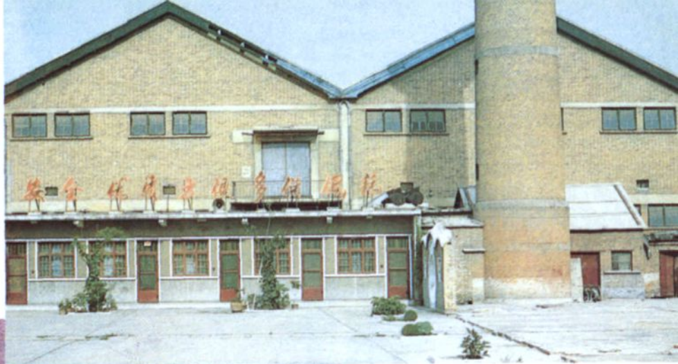
安阳仓库楼库 ▶
