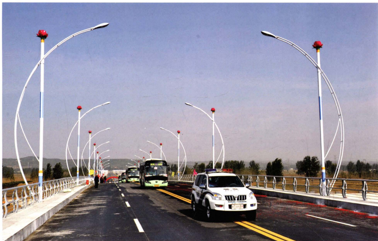
黄河同力大桥
