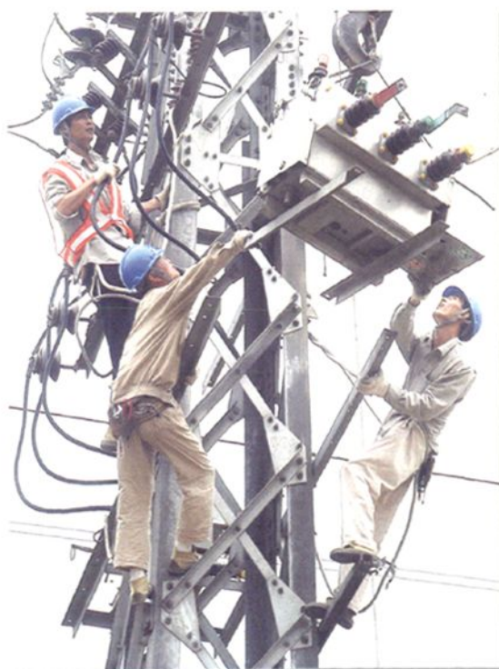
电力工程集团公司职工在海沧紧张施工
