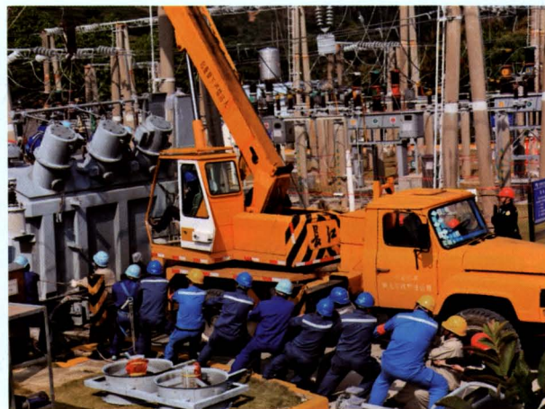
齐心协力吊装变压器
