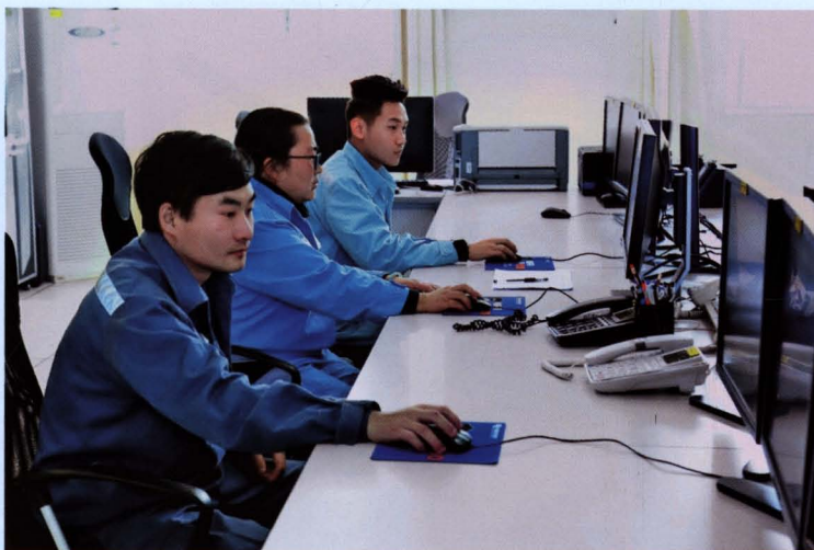
全神贯注变电运行
