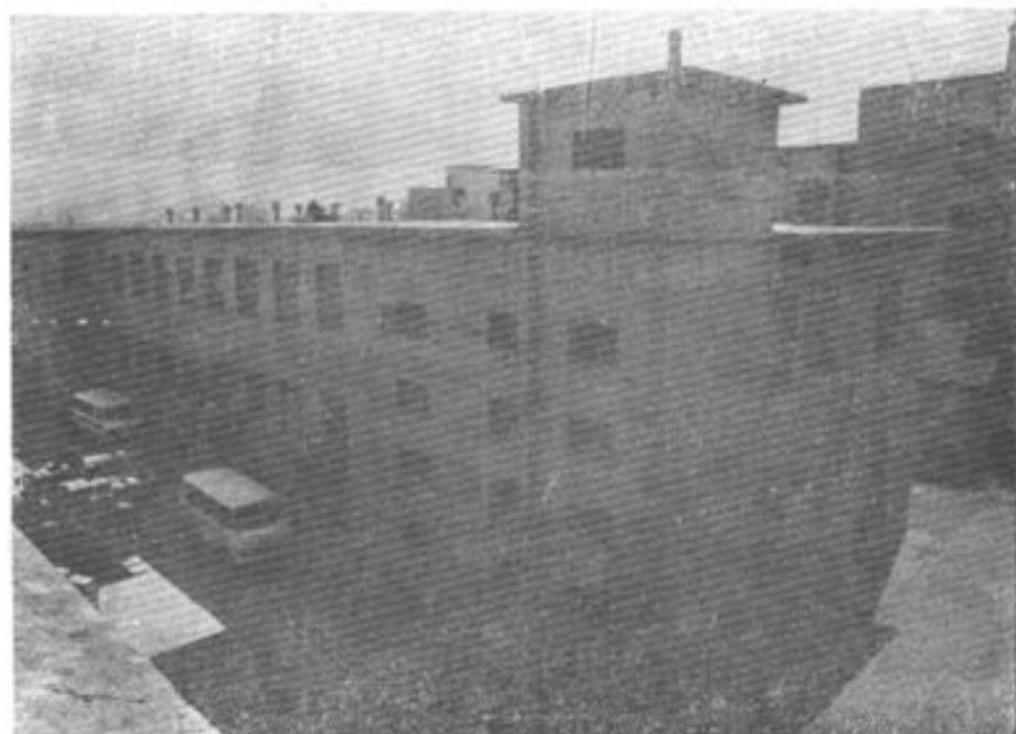
一九八一年膏药车间楼建成投产
